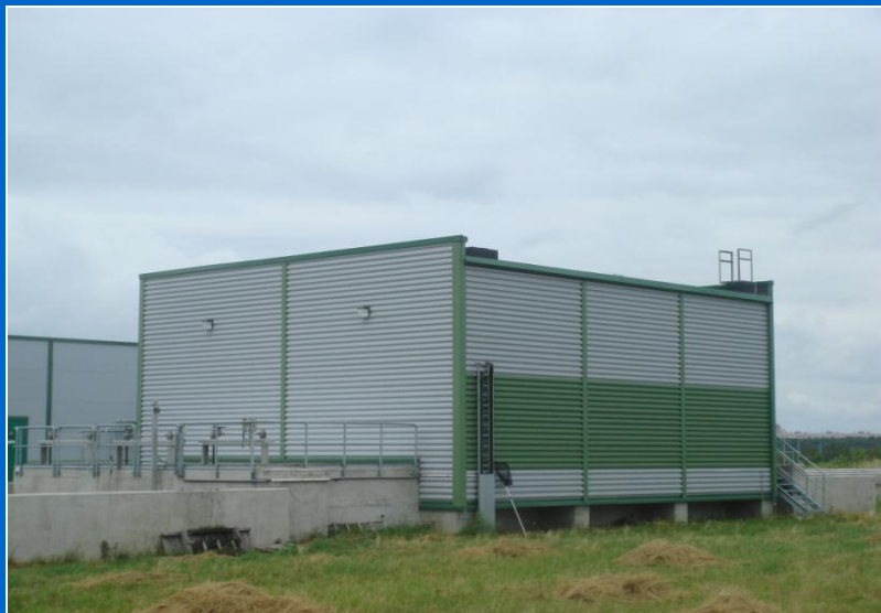
Юго-Западные очистные сооружения, г. Санкт-Петербург 330 000 м 3 /сут
