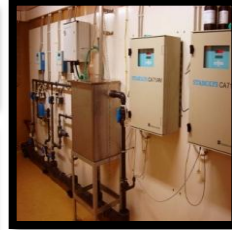
Пуск системы on-line контроля качества очистки сточной воды на ЦСА
