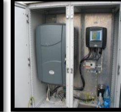
Пуск системы on-line контроля качества очистки сточной воды на ССА и ЮЗОС
