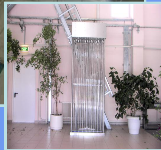
Отделение УФ-обеззараживания состоит из 64 модулей типа 88 МЛВ-36А-2-300-М
