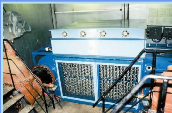
Испытания напорной установки УДВ 1000/288 для УФ-обеззараживания производства НПО "ЛИТ" на Зеленоградских очистных сооружениях. 1997-1998гг.
